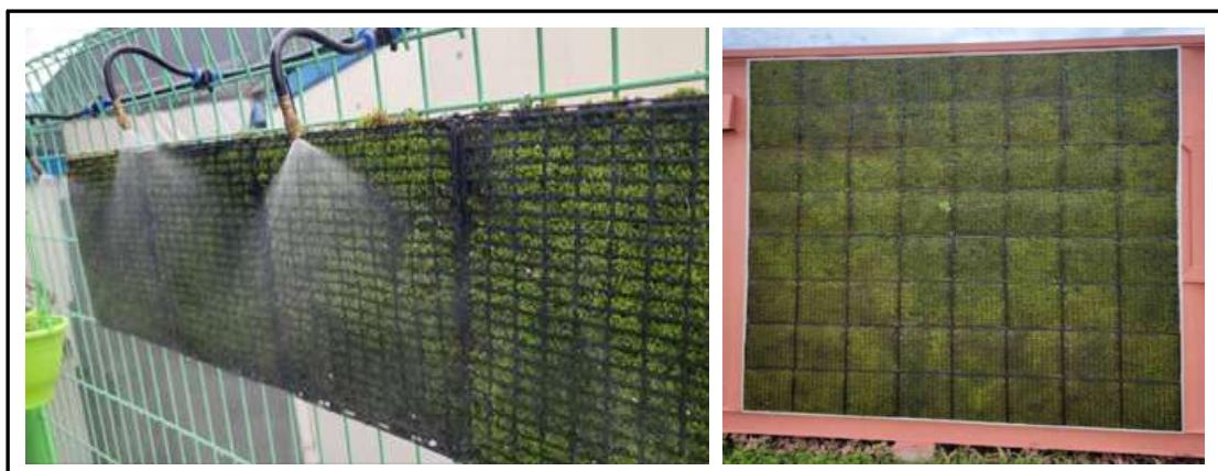
그림 26. 울타리(좌) 및 벽면(우)에 설치된 수직 이끼네트
